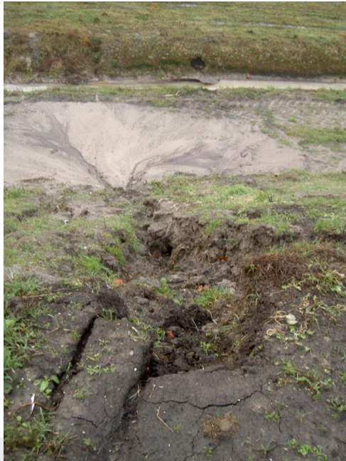
Foto: Erosie van afdeklaag.
