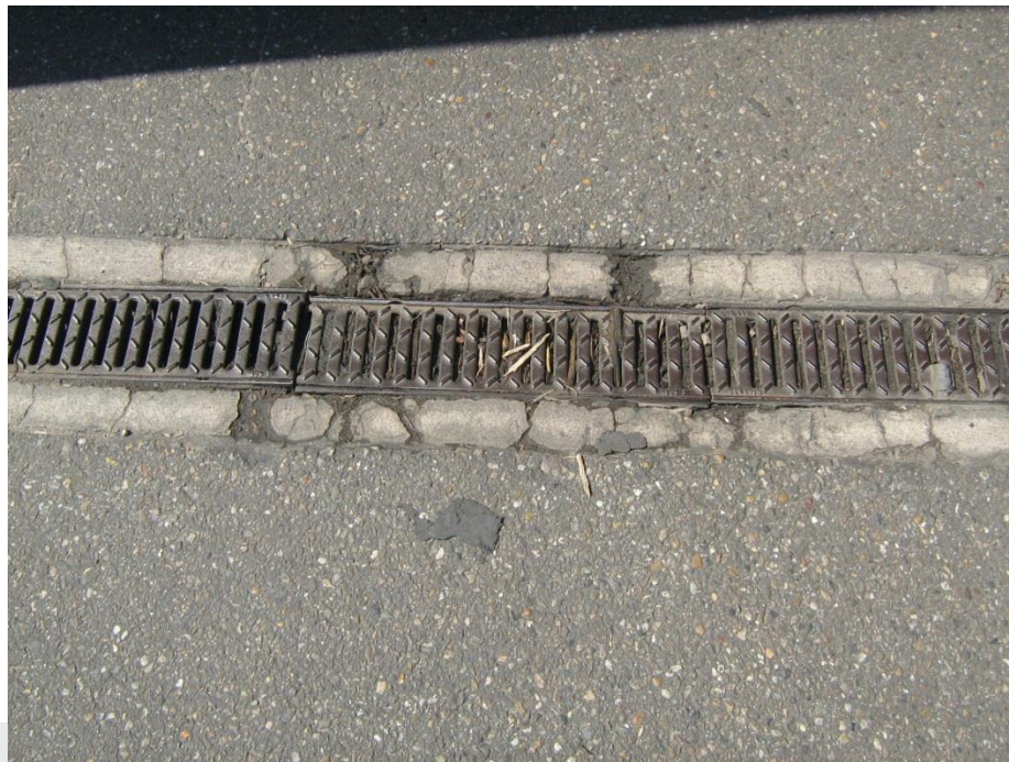
Foto: Aansluiting op lijngoot.
