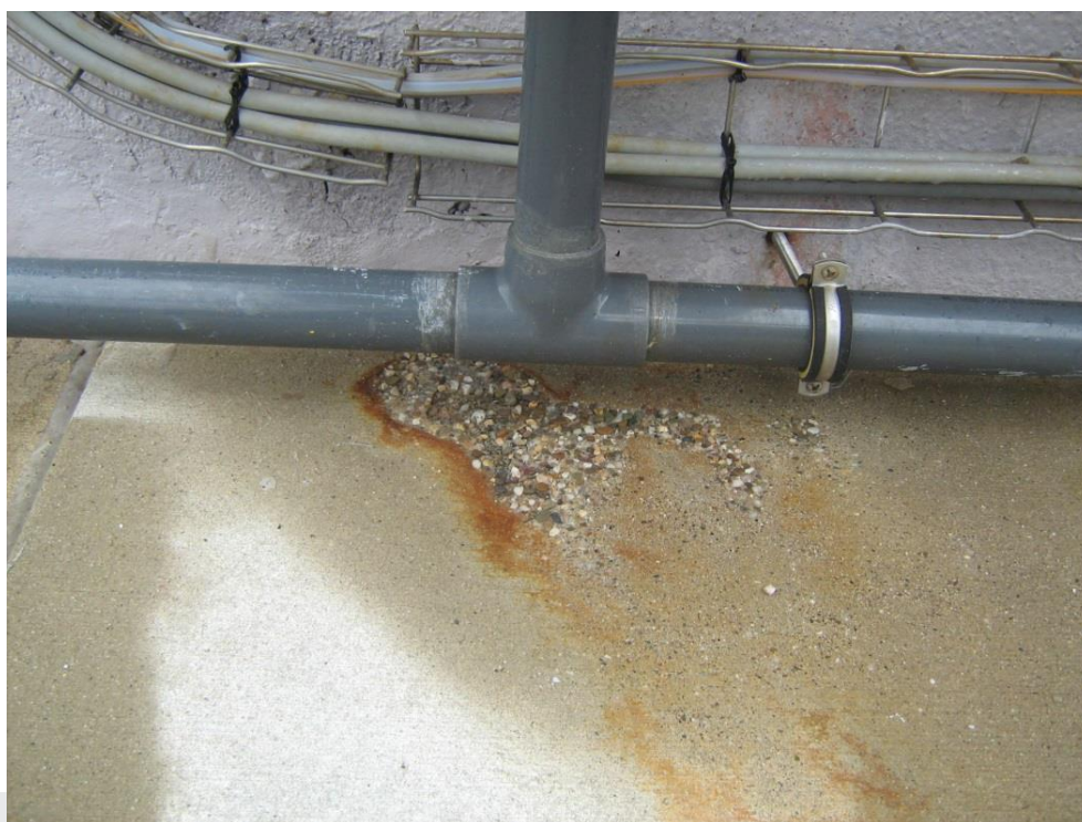
Foto: Voorbeeld van chemische aantasting.
