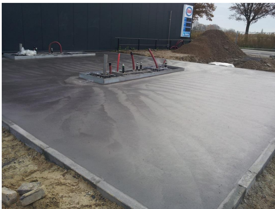
Foto: Aanleg van vloeistofdichte betonvloer.
