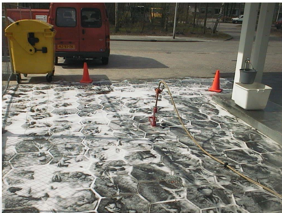
Foto: Inspectie uitgevoerd overeenkomstig protocol 6704.
